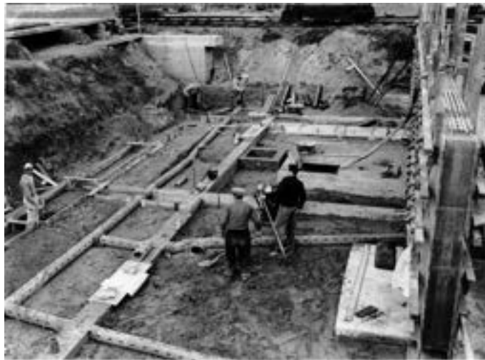
Baugrube für den unterkellerten Teil (Toiletten, Heizung)
