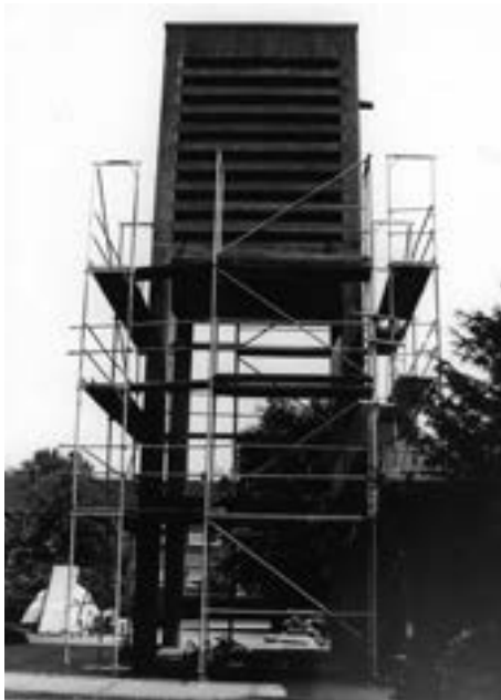
Der Turm ist zur Betonsanierung eingerüstet
