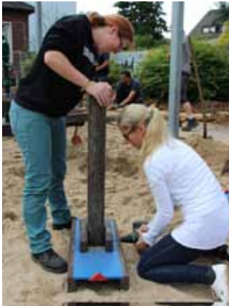
Frauenpower beim Zusammenbau der einzelnen Elemente der Wasserrinnen und des Auffangbeckens
